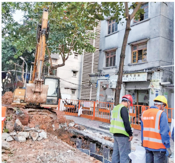
施工现场。通讯员许铭兵 摄
