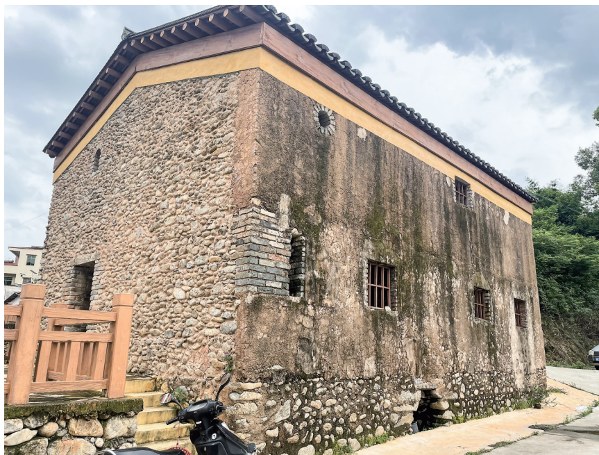
高州市大坡坑塘碾米作坊,建于民国时期。
