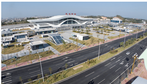
广湛高铁茂名南站。茂名日报社全媒体记者甘杨松 摄
