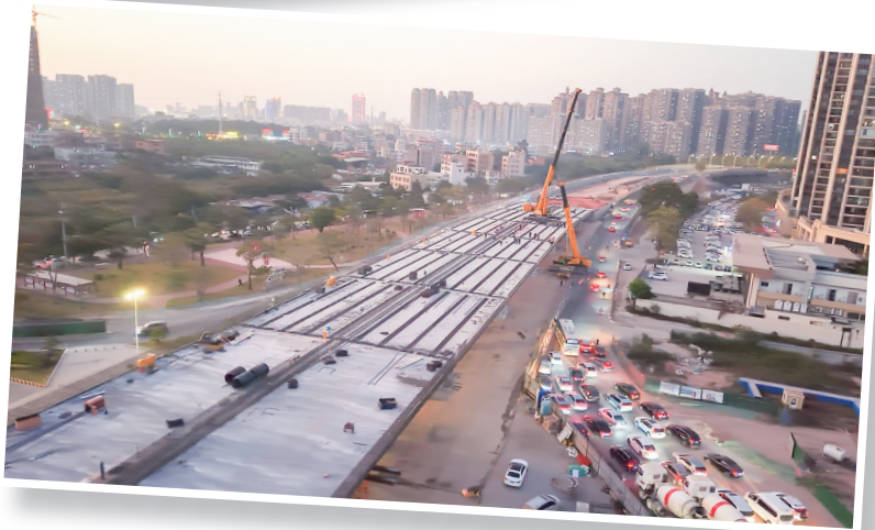
茂南大道立交主线全线贯通。 本版图片由茂名日报社全媒体记者刘付思明 黄宇彬 摄
