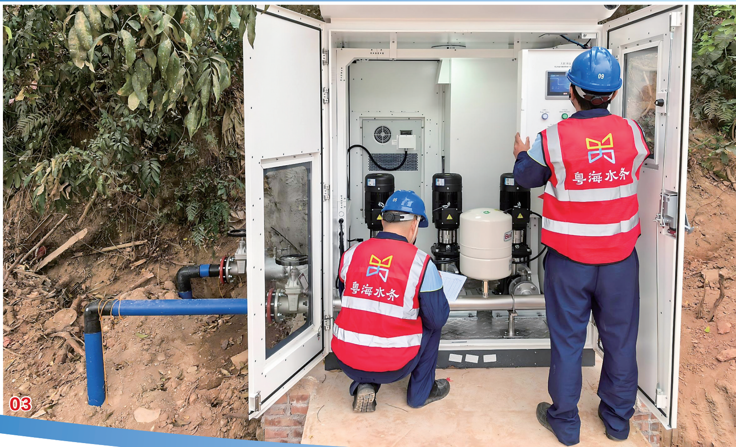
工作人员对加压泵站进行调试。
