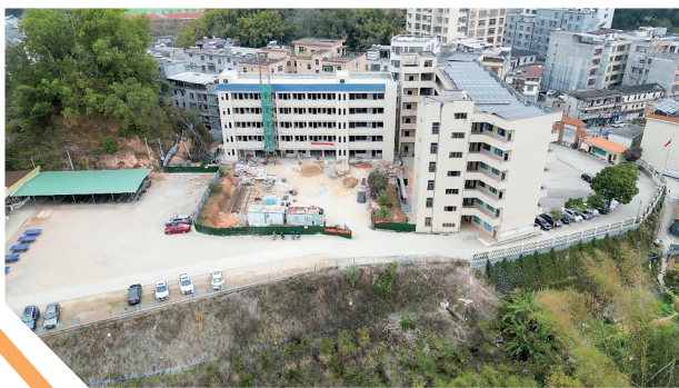
安莪中心小学学生宿舍楼建设中。
