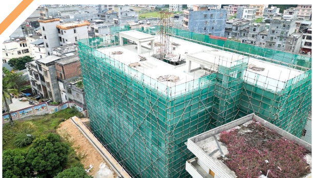
合水中心小学综合楼推进建设。
