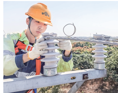
工作人员对存在隐患的设备进行更换作业。
