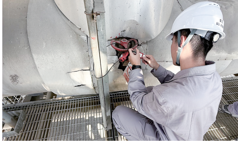
实践队员正在进行“挂牌”“上锁”安全措施。
