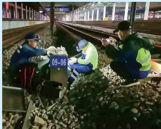
管道工区全面开展供水设备专项整治行动。
