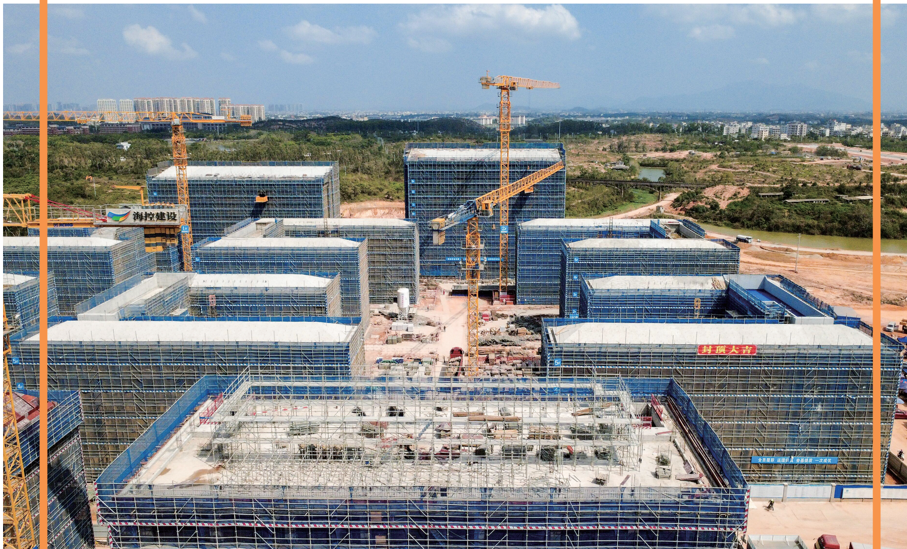
茂名一中新城校区项目施工现场。 茂名日报社全媒体记者梁瑜智 见习记者李泽贤 摄
