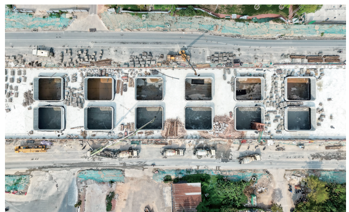
隧道天窗施工现场。茂名日报社全媒体记者吴昊 摄
