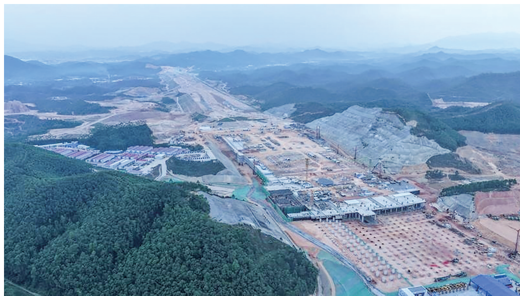
3月24日拍摄的广州新机场所在地(无人机照片)。
