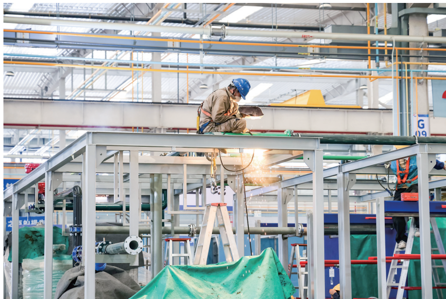
高州申菱特种空调有限公司,工人在厂区组装设备。
