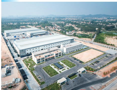
中财管道厂房航拍。
