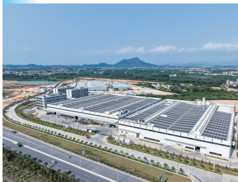
高州申菱特种空调有限公司厂房航拍。
