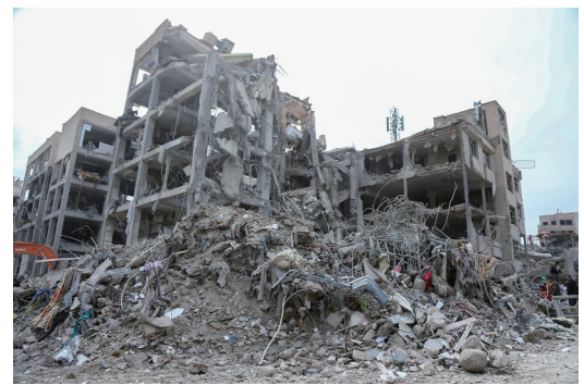
这是3月12日在伊朗德黑兰东部一处居民区拍摄的被毁房屋。新华社记者沙达提 摄
