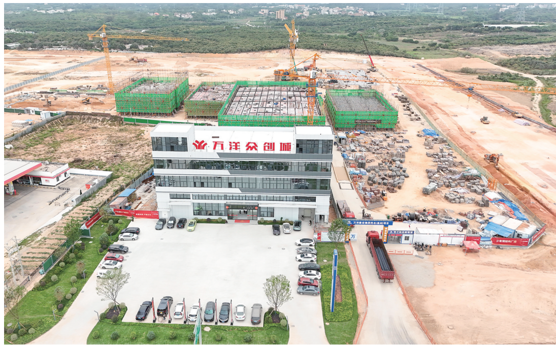
高州万洋众创城建设现场。通讯员供图
