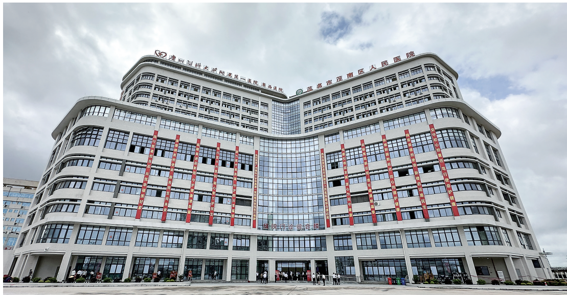
茂南区人民医院新综合楼全景外观图。
