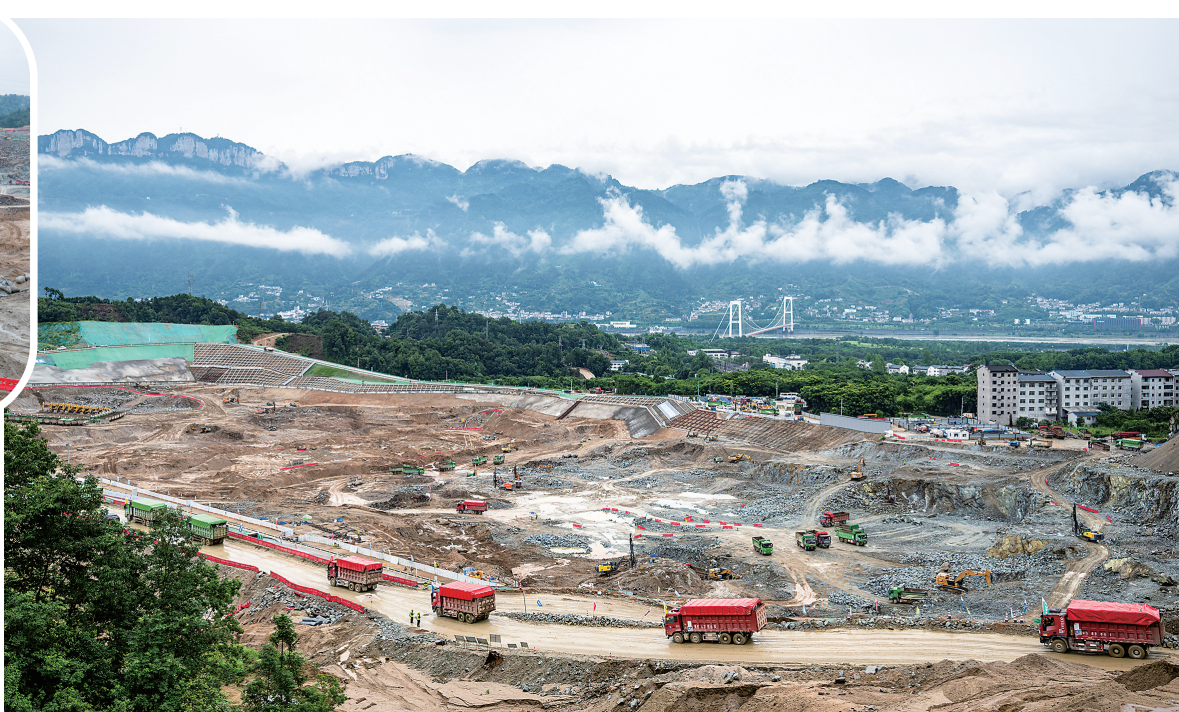
这是6月8日拍摄的三峡水运新通道工程先行开挖区施工现场。 新华社记者 伍志尊 摄
