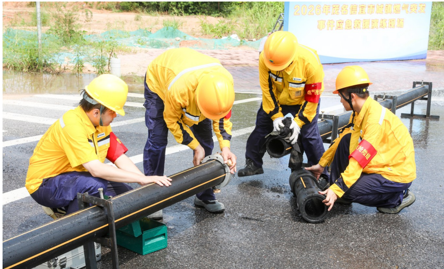
工程技术人员对破损天然气管道进行抢修。
