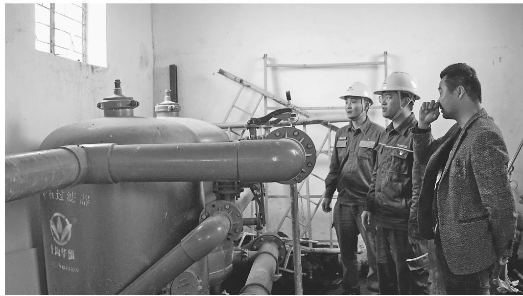
供电人员到用户灌溉系统泵房检查用电。黄舒娴 摄
