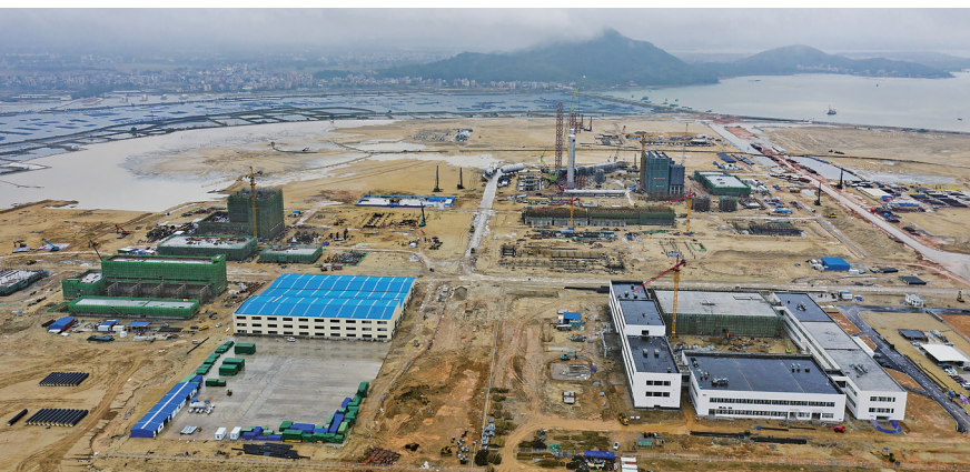
吉达港东华能源院烃资源综合利用项目建设现场。本报记者 丘立贺 摄
