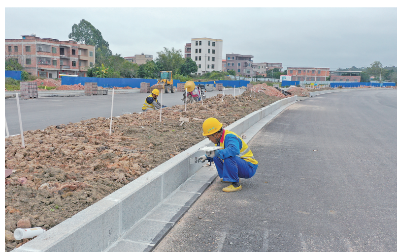
工人在为路面隔离绿带带缝。茂名日报社全媒体记者 闵灿 摄
