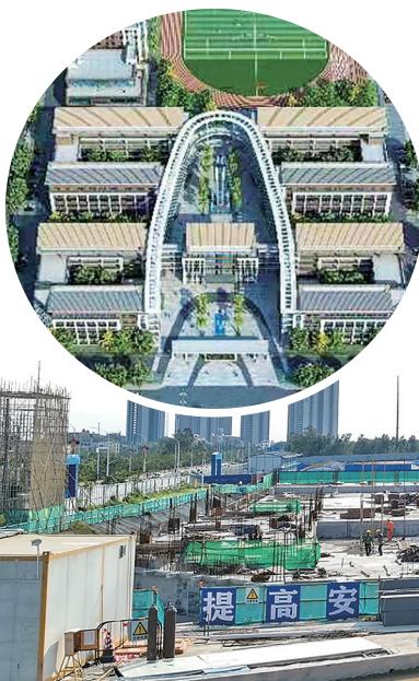
茂名市茂南第一实验学校教学大楼正在建设中(小图为俯瞰效果图)。茂名日报社全媒体记者 岑稳 摄
