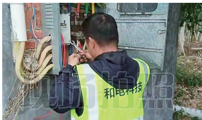
▲技术人员在安装TPT公司的ELPD安全用电末端处理器。
