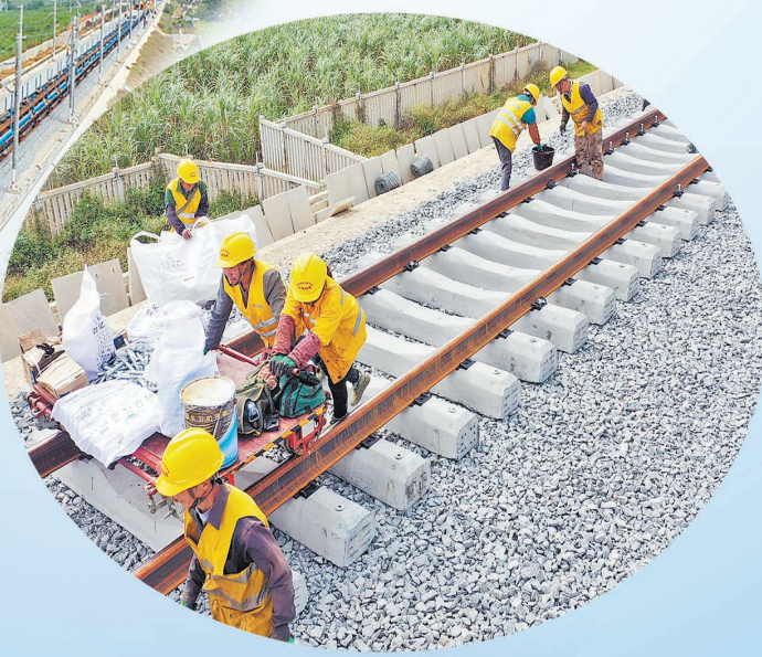
工人们正在工地上施工 凌渐俊 梁盛 摄
