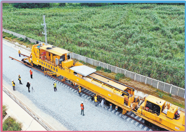
CPG500型铺轨机正在施工 凌渐俊 梁盛 摄
