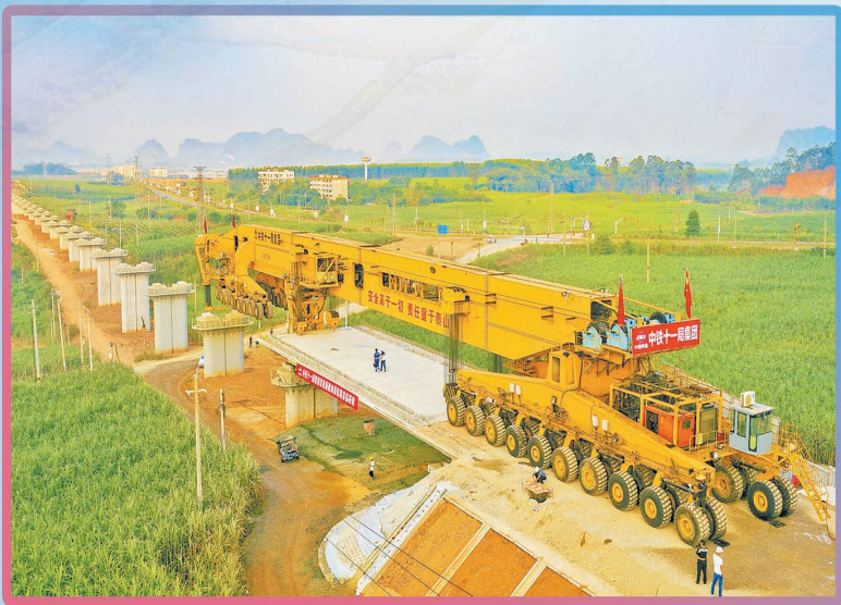
架梁现场 姚庆龙 摄
