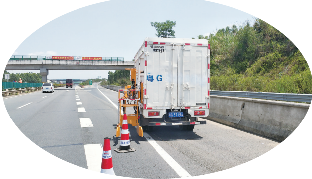
路锥自动收放车在茂湛高速改扩建TJ6标涉路施工现场作业。 通讯员 张丽珊 李达隆 摄
