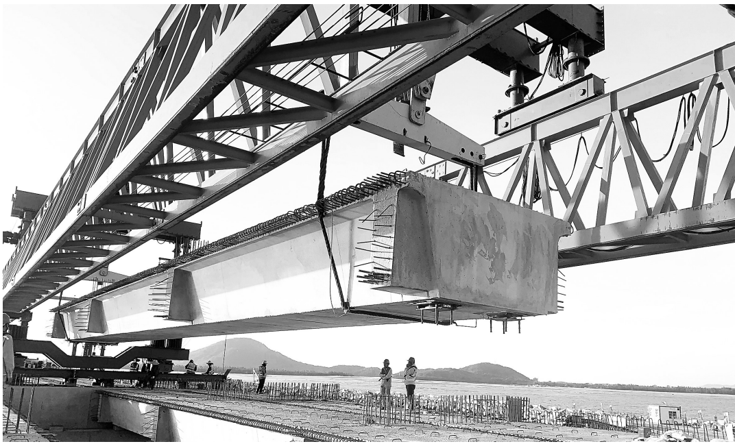
预制箱梁吊装现场。
