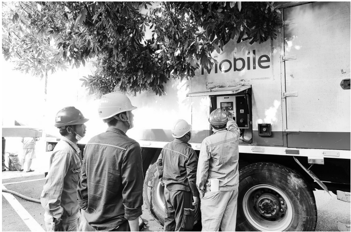
6月7日,茂名电白供电局与移动公司在电白区第一中学高考考点共同开展应急电源联动互通,为保供电上多一道保险。
