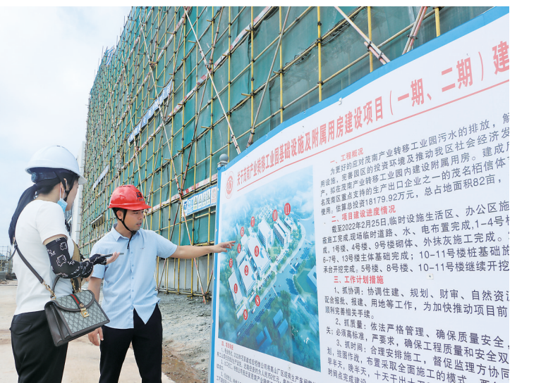
施工方向记者介绍工程建设情况。茂名日报社全媒体记者 吴云杰 摄
