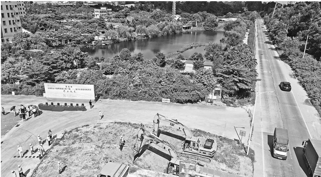
昨日,复兴大道延长线项目开工。茂名日报全媒体记者 黎雄 摄
