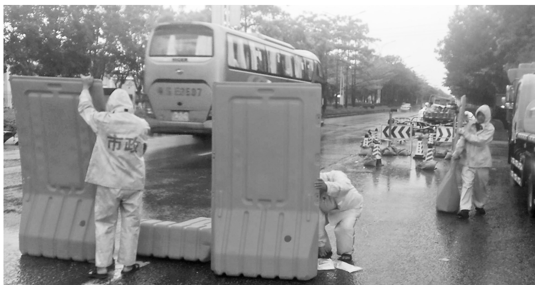
市政人员对施工区域设置警示,做好安全防护措施。
