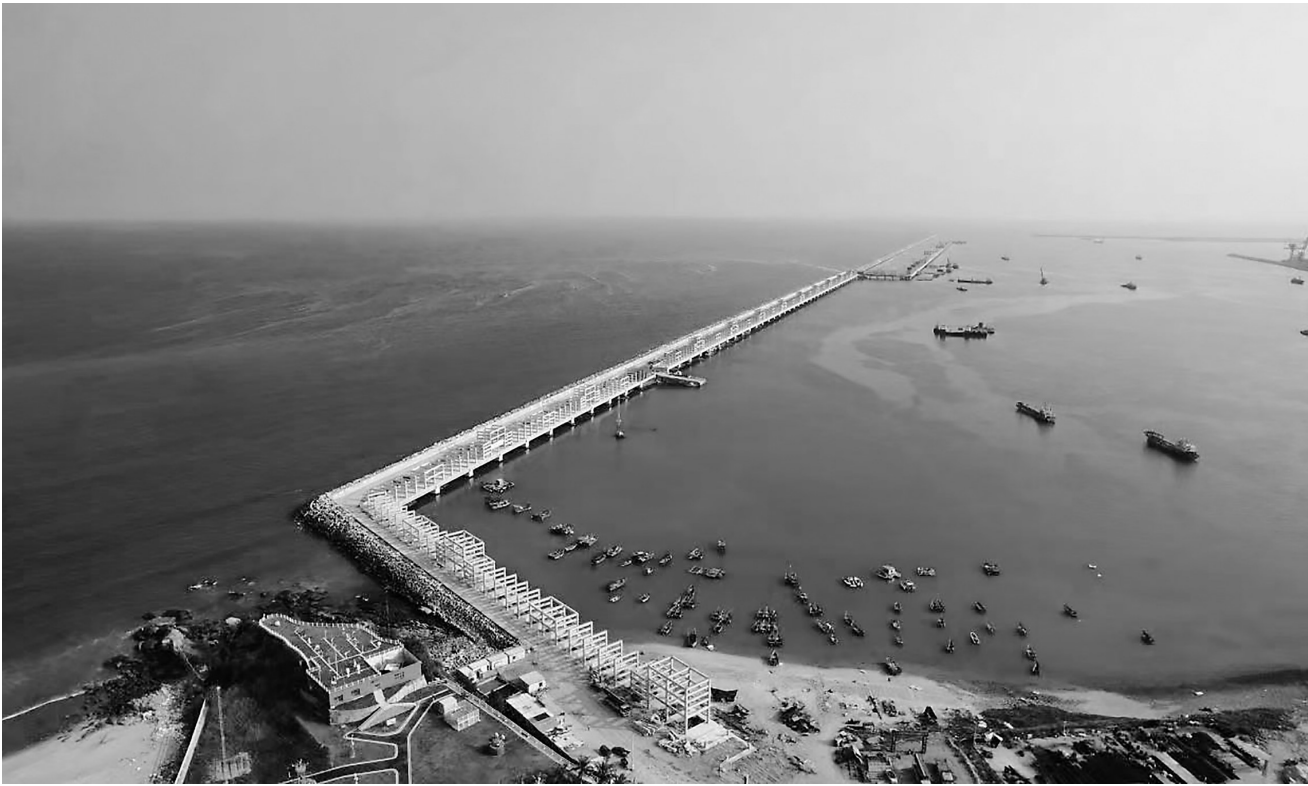
茂名港博贺新港区东区油品码头工程项目施工现场。
