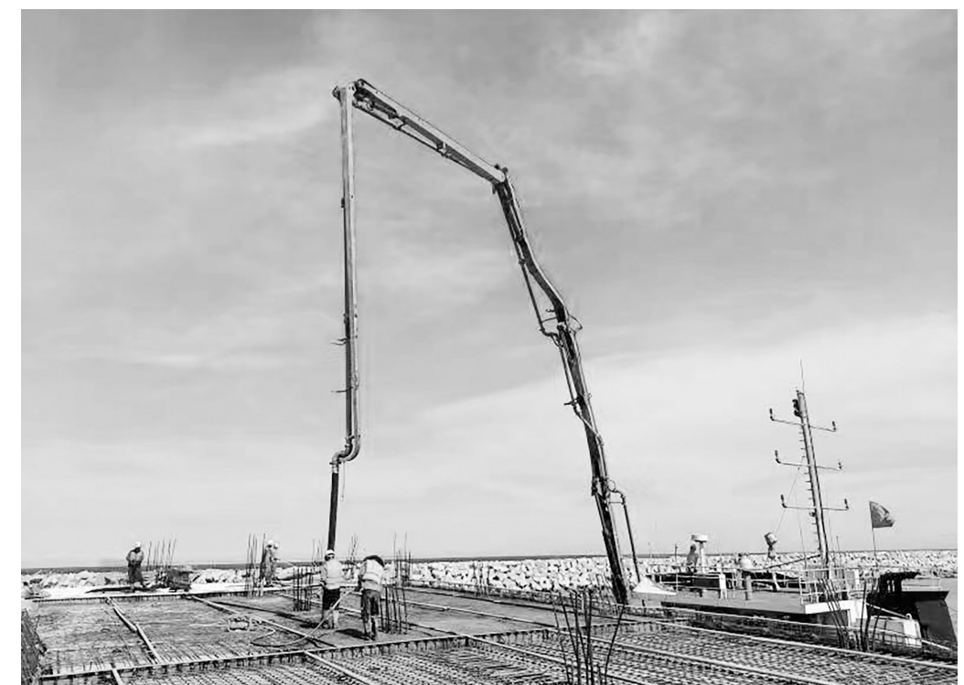
油品码头工程水域公用管廊栈桥面层浇筑施工。
