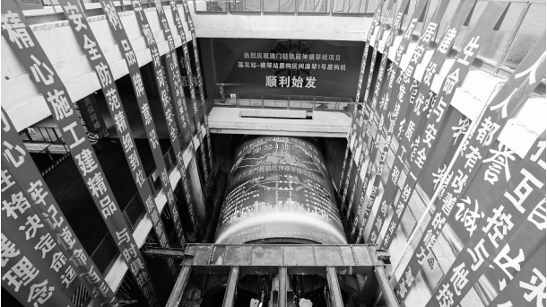
澳门应用最大直径盾构机“澳琴1号”(7月13日摄)。新华社记者张金加摄
