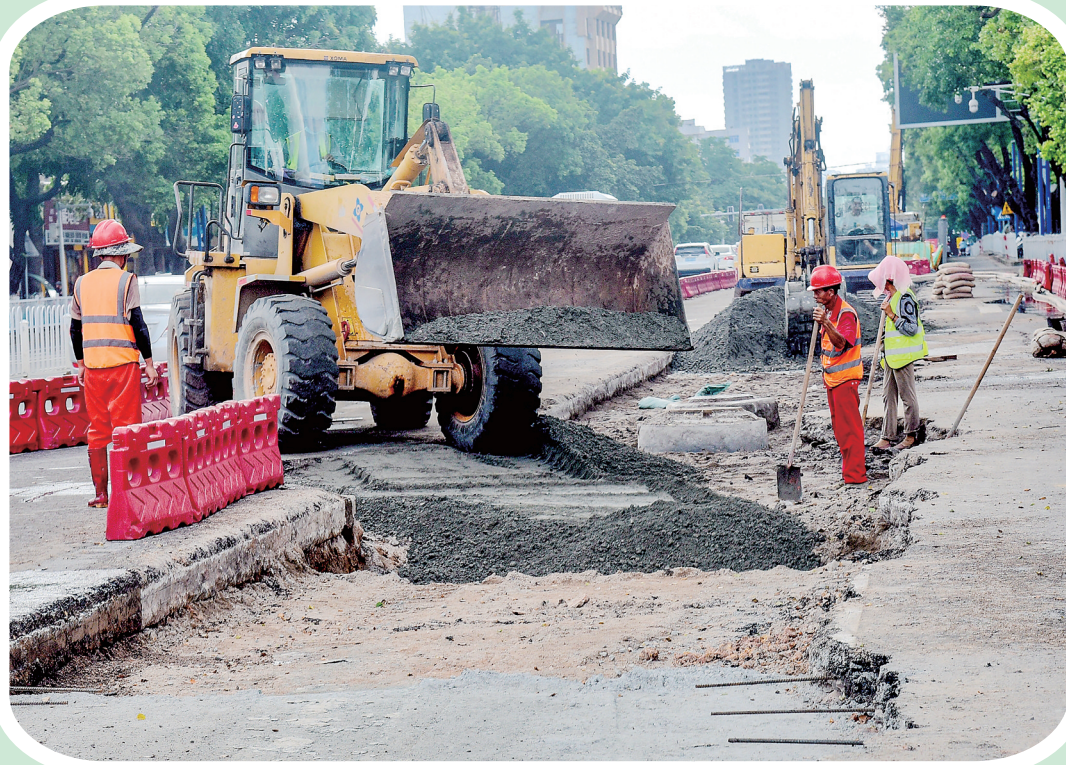
昨日，记者在市区油城三路污水管网建设施工现场看到，施工人员正在进行污水管道沟槽回填施工。据施工方介绍，该工程预计8月中旬完工。 茂名日报社全媒体记者 陈国汉 摄
