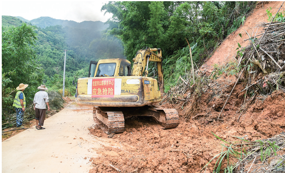
施工人员在清理路障。茂名日报社全媒体记者 黎雄摄
