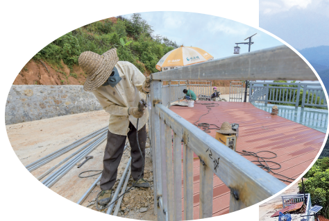
建设工人在进行收尾阶段的工作。
