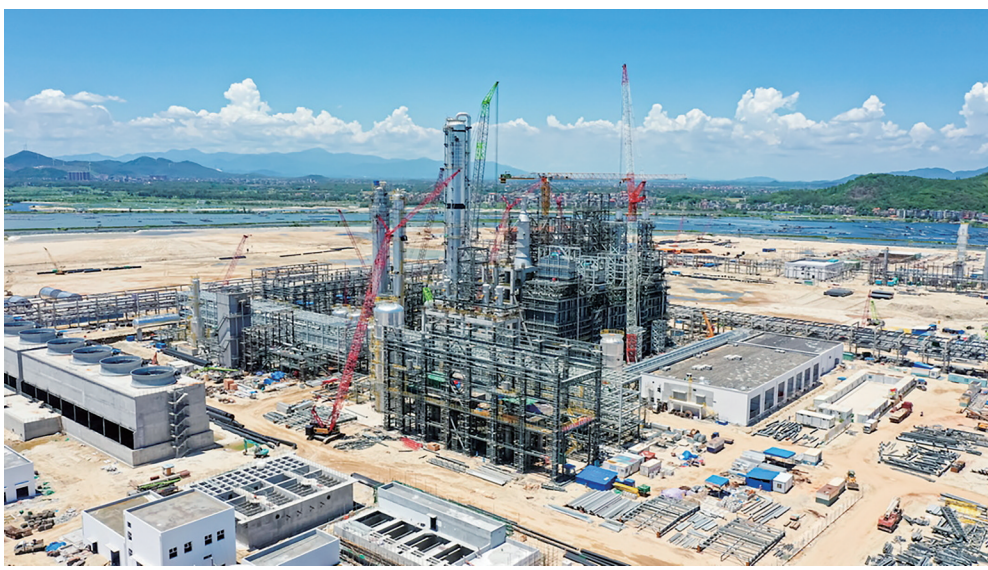
东华能源烷烃项目聚丙烯装置进展顺利。
