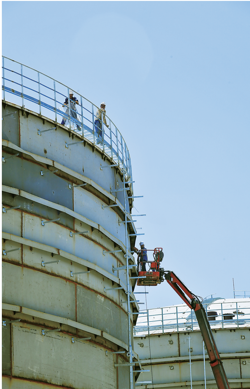
工人在焊接博贺新港区东区化工码头仓储油罐。
