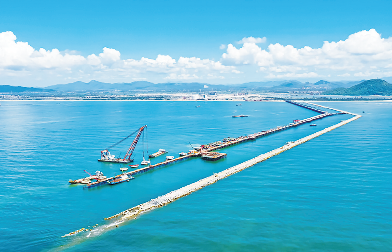
茂名港吉达港区防波堤一期项目建设蹄疾步稳。本报记者 闵灿 摄
