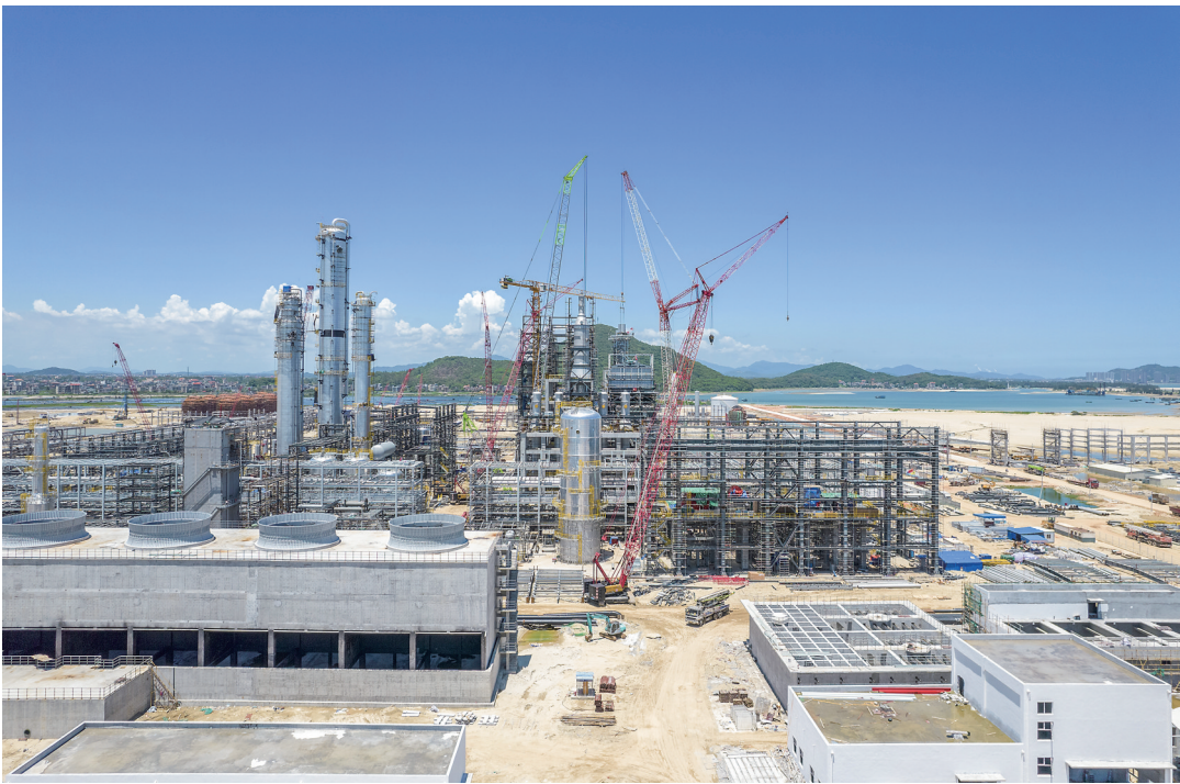
东华能源烷烃项目聚丙烯装置进展顺利。茂名日报社全媒体记者 周泽佳 摄
