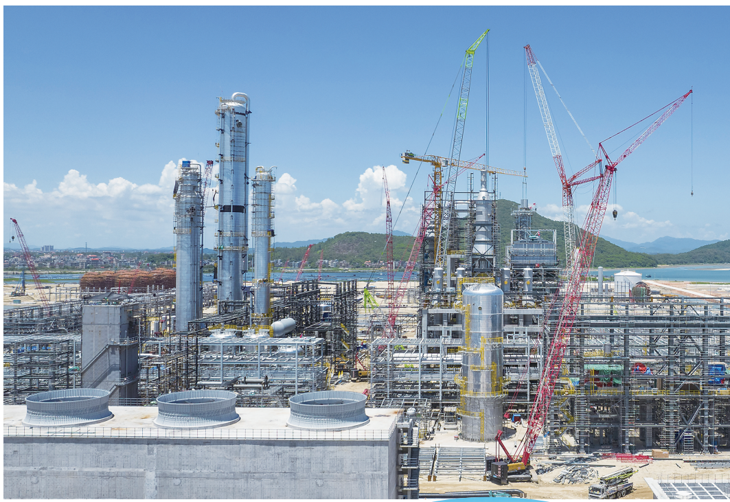
东华能源烷烃项目聚丙烯装置吊装。周泽佳 摄
