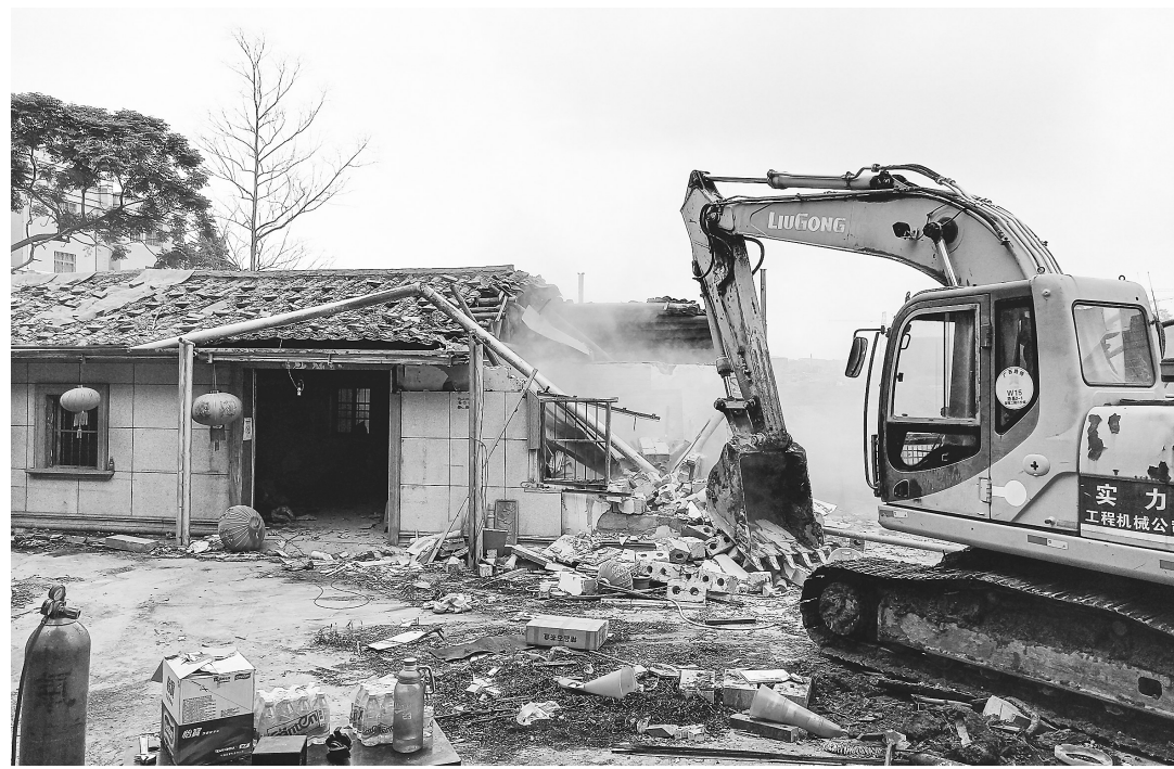
双山八路拆迁工作全面完成,项目顺利推进。
