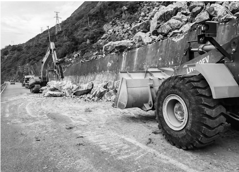
9月6日上午,工程机械在省道S217线泸石路快速通道K30二里坝段进行抢通作业。新华社发
