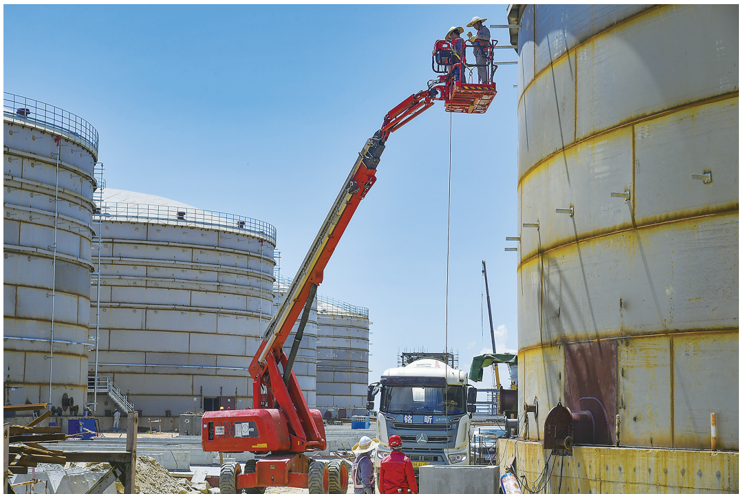
博贺新港区东区化工仓储项目罐区建设进展顺利。茂名日报社全媒体记者 丘立贺 摄
