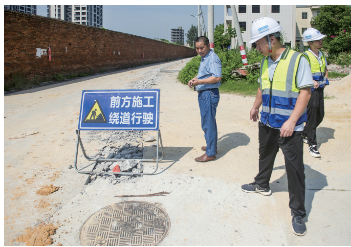
工作人员在检查南海片区雨污管网。茂名日报社全媒体记者 周泽佳 摄
