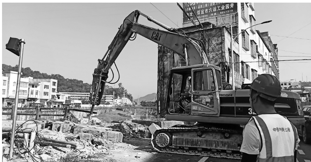
拆除旧桥现场。通讯员 黄益博 摄
