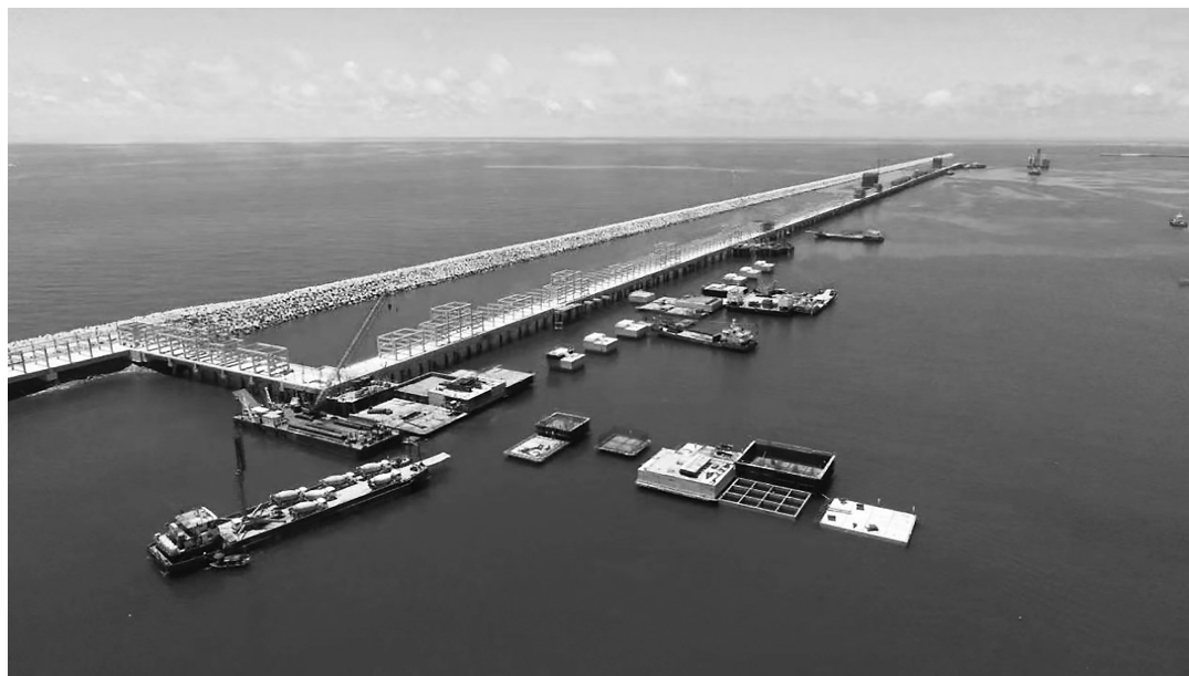
10万吨级成品油码头海上公共管廊项目。茂名港集团供图
