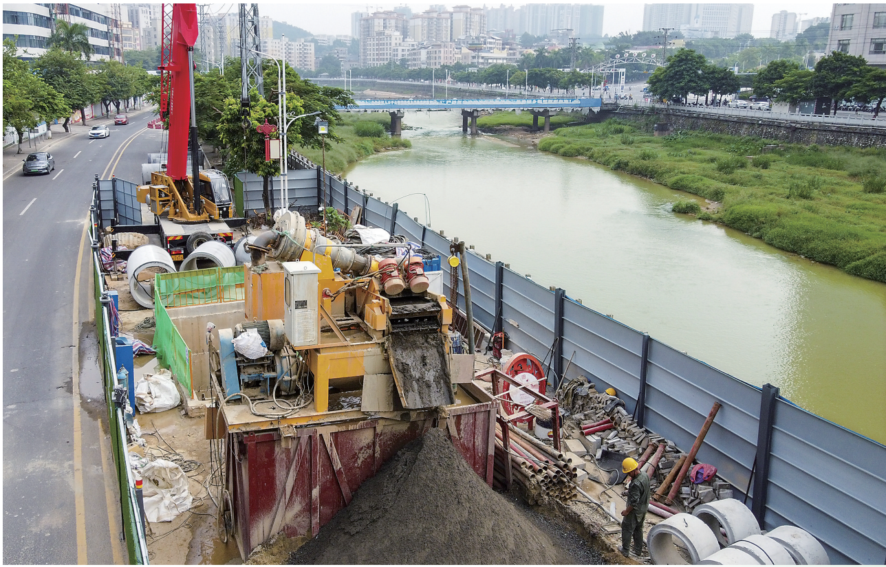
建设中的信宜市东江河污水管网改建工程。茂名日报社全媒体记者 甘杨松 摄
