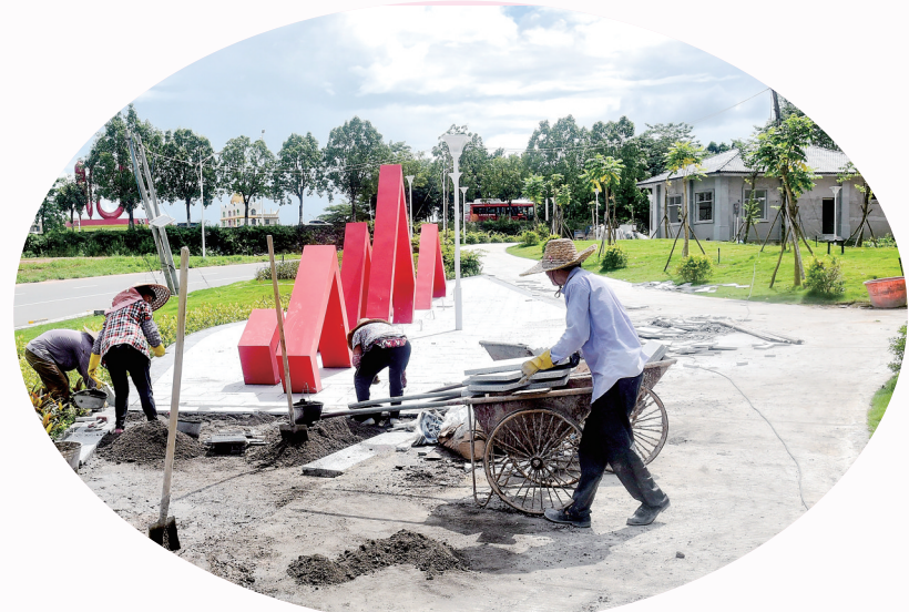
10月3日，在市区站北七路社区体育公园施工现场，施工人员放弃国庆假日休息，坚守岗位，正在加紧铺设公园地板砖，争取早日建成开放。 茂名日报社全媒体记者 陈国汉 摄
