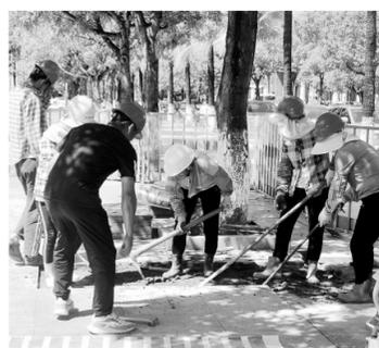
昨日，市区文化广场雨污分流改造工程开始施工，施工人员正在进行排水管道沟槽开挖施工。据施工方介绍，该工程预计工期为30天。
