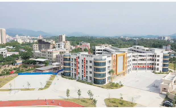
2021年8月，沙琅镇新城小学改扩建竣工投入使用。
