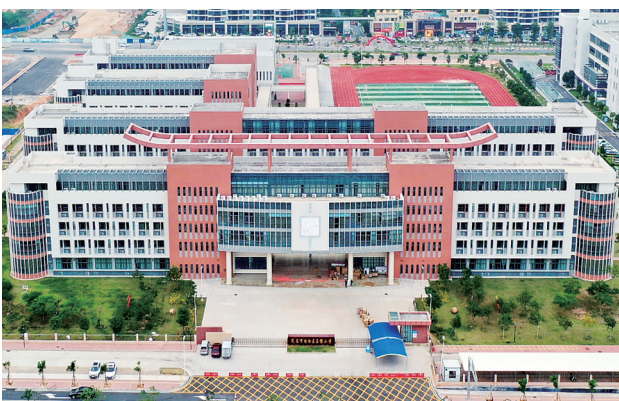
2019年9月，电白区占警小学竣工投入使用。
